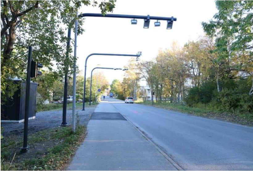
Bilde: Bomstasjon i Bodø. Innkrevingsutstyr og teknisk bygg (til venstre i bildet).
